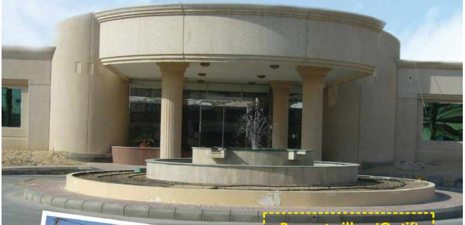
Precast villas (Qatif)
